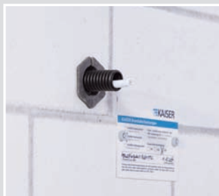
Breng na montage van het schot de markering aan.
