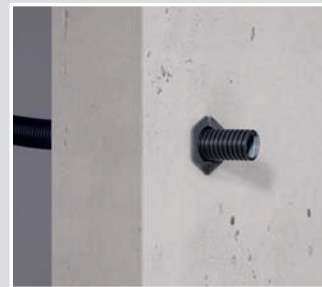
Wanddoorvoer door brandwerende betonwand.
